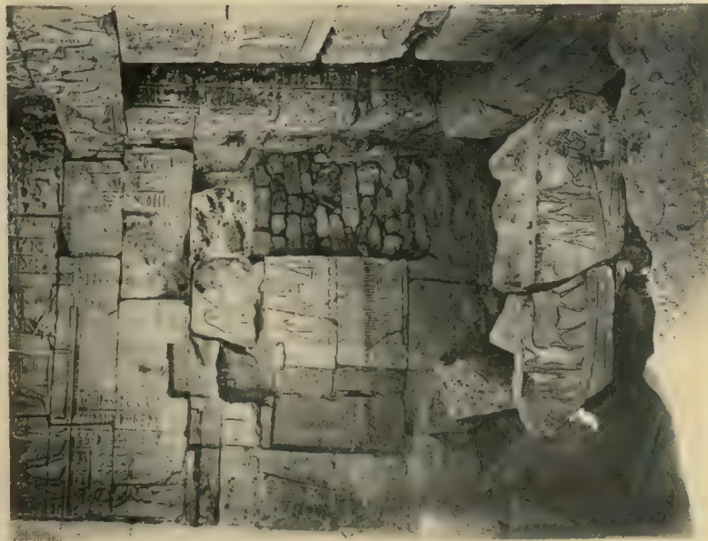
Les débris de l'escalier avant la restauration.
